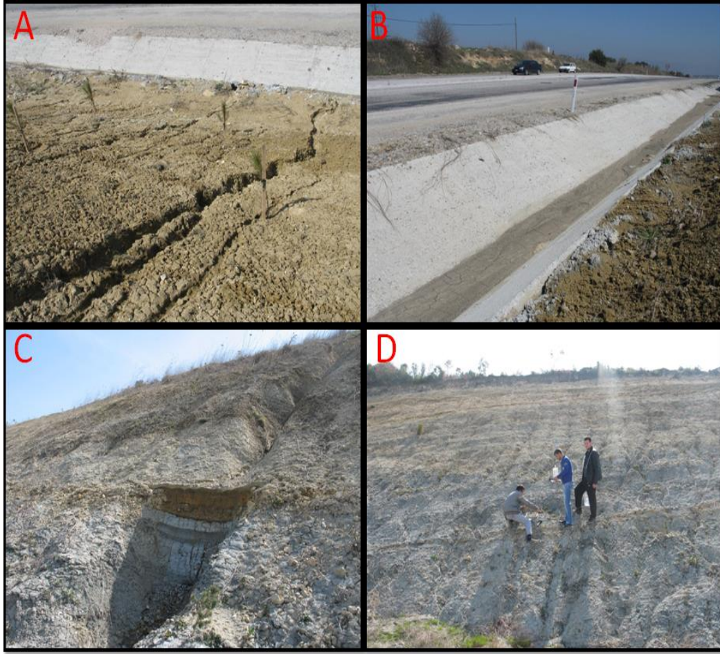
Şekil 2. Çanakkale-Lapseki karayolu kenar şevlerinde görülen erozyon tipleri a) Yüzey ve parmak erozyonu b) Kanalda erozyon sonucu sediment birikimi c) Oyuntu erozyonu d) Parmak erozyonu
