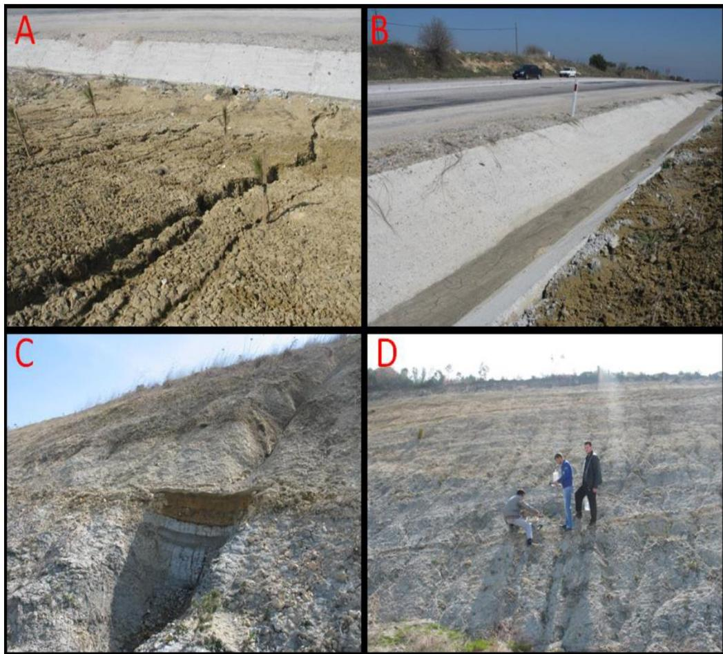
Şekil 2. Çanakkale-Lapseki karayolu kenar şevlerinde görülen erozyon tipleri a) Yüzey ve parmak erozyonu b) Kanalda erozyon sonucu sediment birikimi c) Oyunlu erozyonu d) Parmak erozyonu
